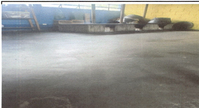
Foto 3: sustitucion de piso de cemento por piso ceramico
