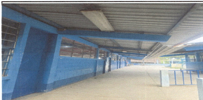
Foto 5: cambio de ventanas por pvc correriza
