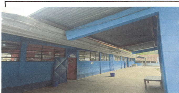
Foto 4: sustitucion de tubo a canales pvc
