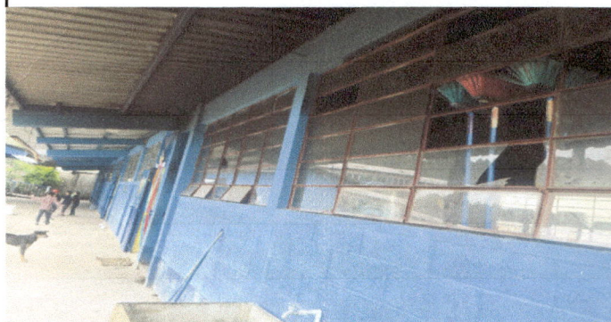
Foto 2: cambio de ventanas metalicas a ventanas pvc
